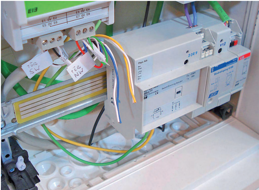
Abb. 5.8: Hier verläuft die Busanbindung über eine Datenschiene und entsprechende Druckkontakte. Neuere Komponenten setzen auf die Busklemme.
