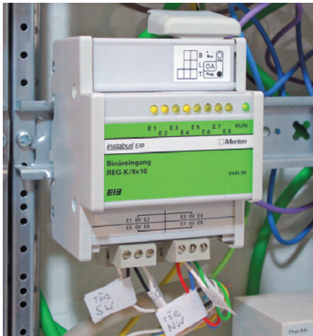
Abb. 11.5: Binäreingangsaktor mit 8 Kanälen zur Abfrage von Tür- und Fensterkontakten.
