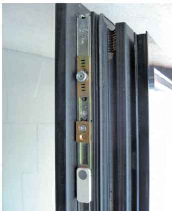
Abb. 11.4: Riegelschaltkontakt zur Verschlussüberwachung von Türen. Der Schaltkontakt ist in den Türrahmen eingelassen und verfügt über eine 4-adrige Alarmleitung.
