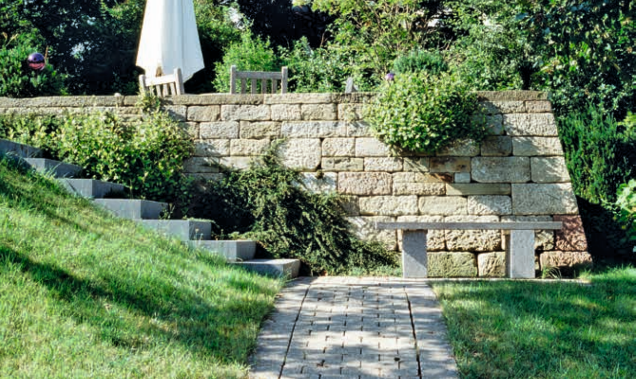
Trockenmauer aus Sandstein mit starkem Anlauf. Fachlich vorbildlich stabil aufgesetzt. Fein gearbeitete Ansichtsfläche mit exakten Fugen.
