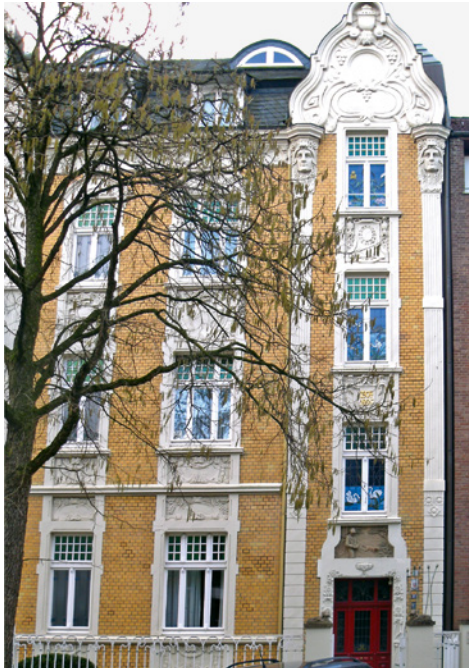
Abb. 1.2: Denkmalgeschütztes Stadthaus in Münster um 1900
