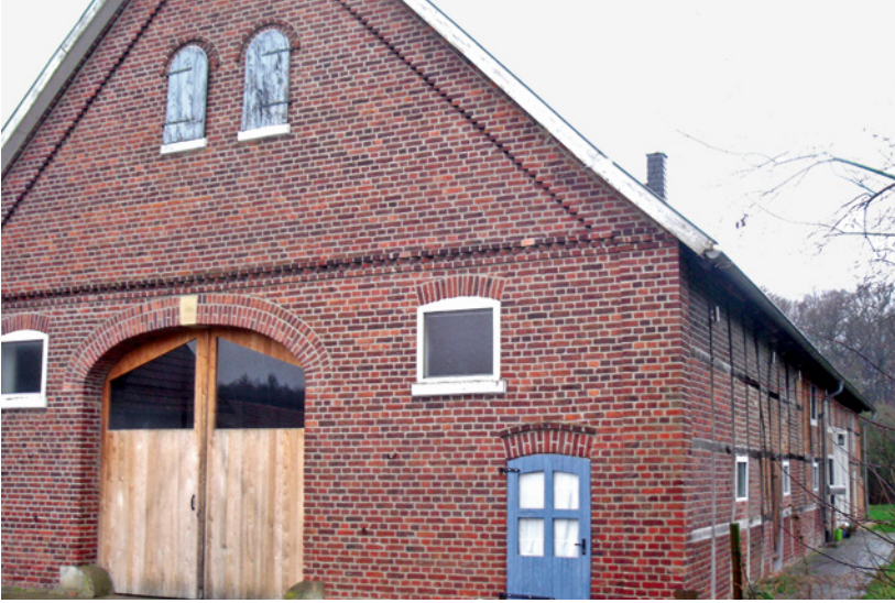
Abb. 1.3: Beispiel für eine Mischbauweise aus Fachwerk- (Hausseite) und Massivbauweise (Giebel) an einem alten Bauernhaus
