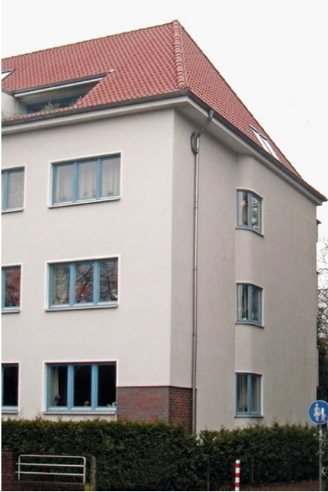
Abb. 1.5: Eckfenster – eine häufige Konstruktionsform der 1930er-Jahre – an einem Haus von 1934
