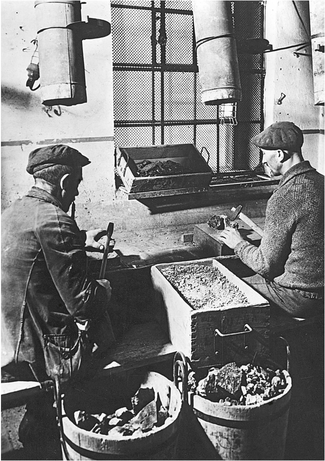
Aufschlagen von Pechblende über Tage
